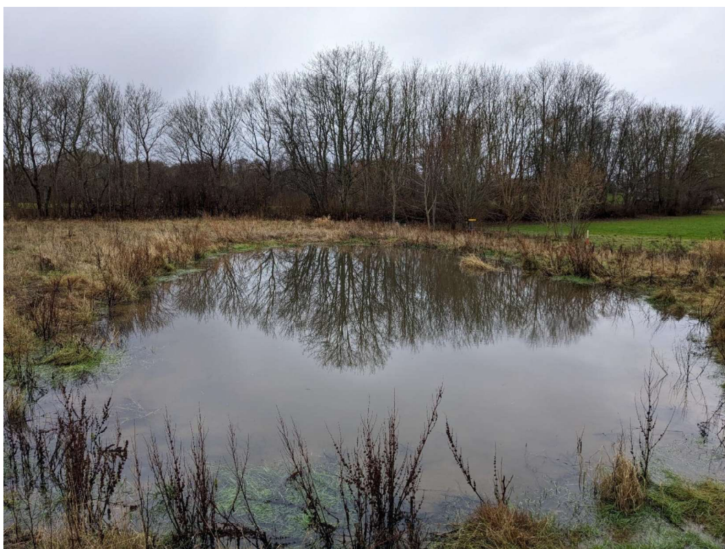
Foto 1 og 2 fra besigtigelse d. 19/12-2023. Øverst: Rensebassin til vejvand. Nederst: nedsivningsbassin.
