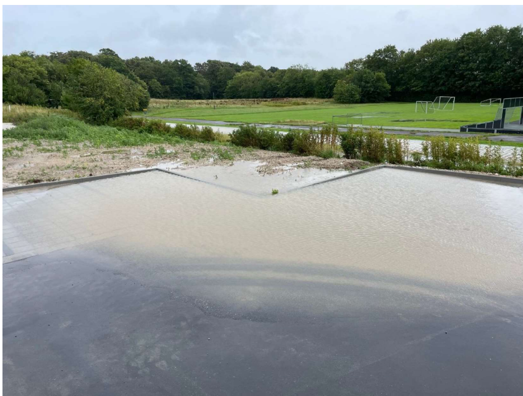
Foto 3 og 4 opstuvning efter kraftig nedbør i august 2023. Øverst: nordligste del af Gymnasiets sportsplads. Nederst: P-arealer ved rensebassin til vejvand.
